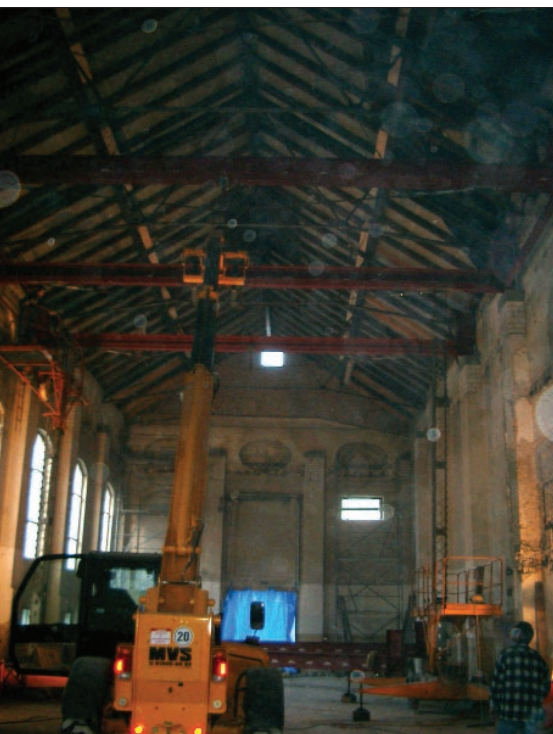
Die entkernte Halle vor dem Beginn der Baumaßnahmen
