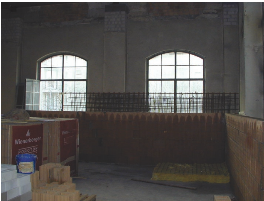
Die massive äußere Raum-in-Raum-Konstruktion des Mischkinos
